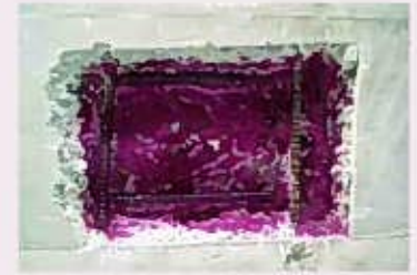
はつりによる 中性化試験
